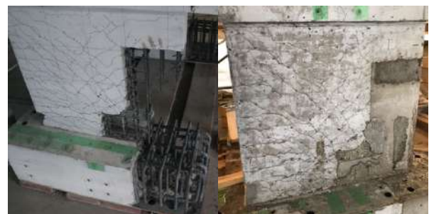
(a)補修前鉄筋切断後 (b)補修後
