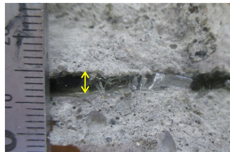
写真-7 水平ひび割れ内部に充填された樹脂
