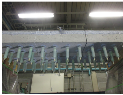
(e) 樹脂注入
