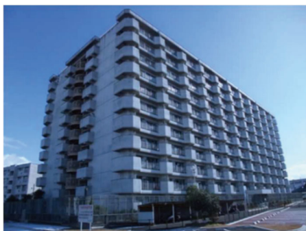
図-1 対象建物の外見
