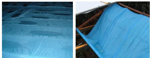
写真-1 ブルーシートによる降雨対策の事例
