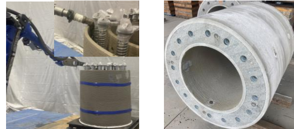
a) 流し込み状況 b) 完成状況 写真-5 流し込み状況および試験体の完成状況
