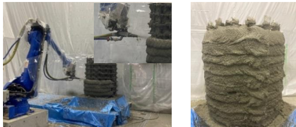
a) 吹付け状況 b) 吹付け後 写真-3 吹付け状況
