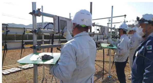
写真-2 自治体職員の断面修復作業の様子
