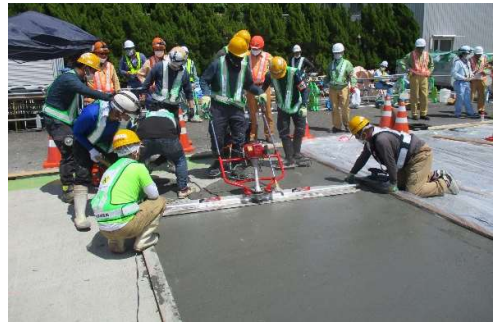
写真-2 UHPFRC 打込み状況
