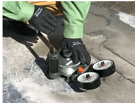
写真-3 建研式引張試験状況
