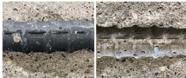
写真-2 含浸材注入後の試験体の解体状況
