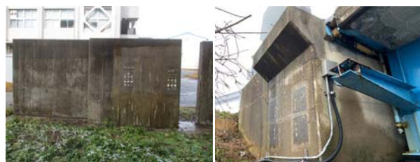
(a) 学内試験用壁 (b) 町道橋の橋台
