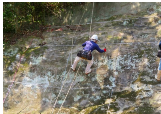
図-2 打音点検状況
