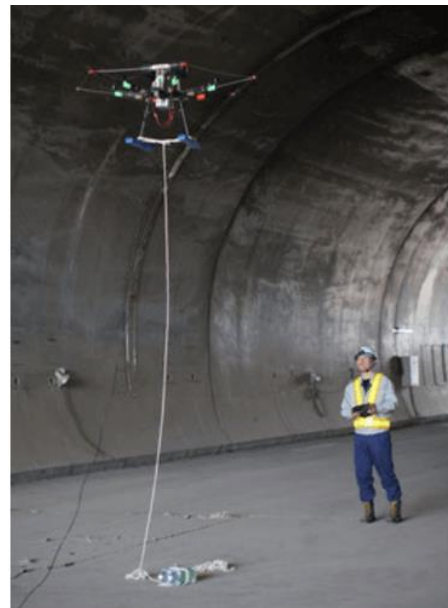
写真-2 ドローンを用いた打音検査装置 4),5)
