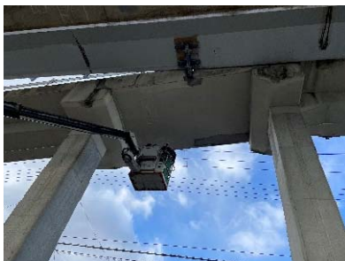
写真-1 高所作業車を使用した打音法による調査状況
