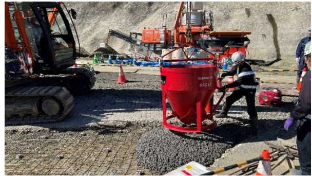
写真-3 打設状況
