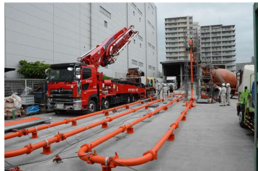
写真-2 配管組立状況 (圧送試験)
