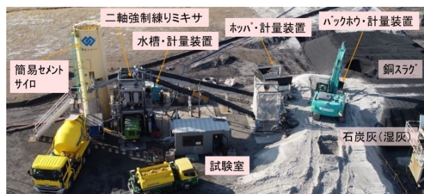
写真－2 製造試験に用いた簡易製造プラント
