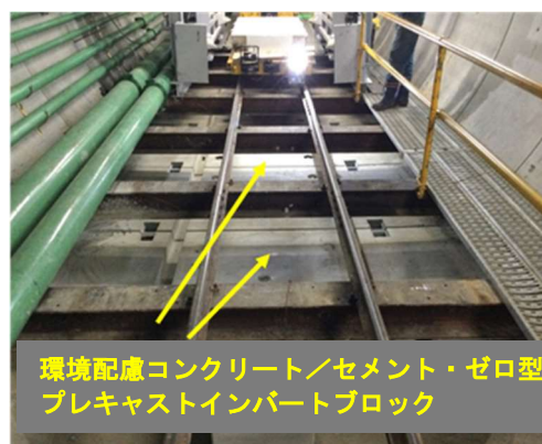
写真-8 環境配慮コンクリートのセメント・ゼロ型の現地適用状況
