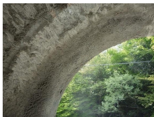
写真-2 天端付近の状況
