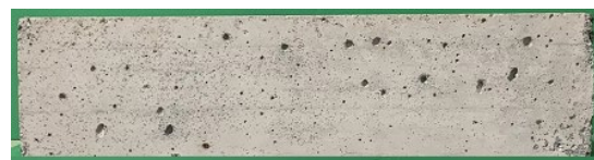
図-16 300 サイクル終了後の供試体表面 (AAM コンクリート)
