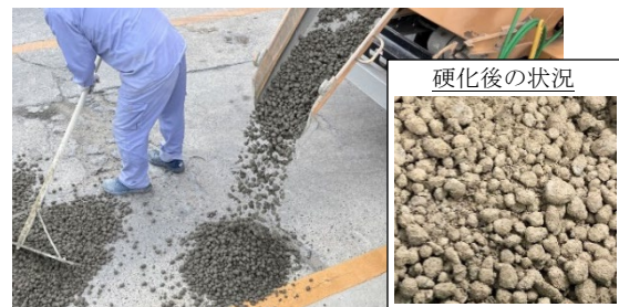
写真-1 粒状化時および硬化後の状況
