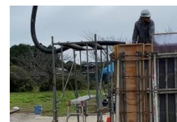
写真-1 打込み口
