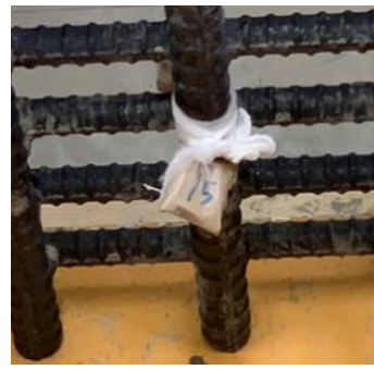
写真-6 無線 IC タグ設置方法
