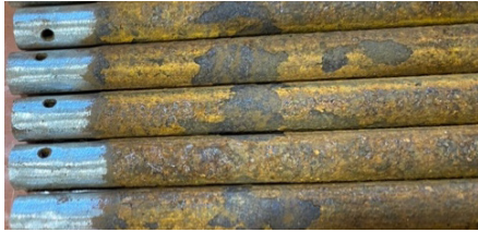
図-3 打設前に事前腐食させた鉄筋の様子
