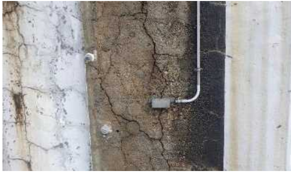
写真-5 A橋・橋台のひび割れ幅の亀裂変位計によるモニタリング状況
