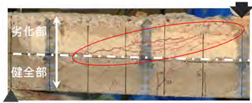
写真-5 凍害を与えた RC 梁の静的載荷で発生した複数本の斜めひび割れ 3)
