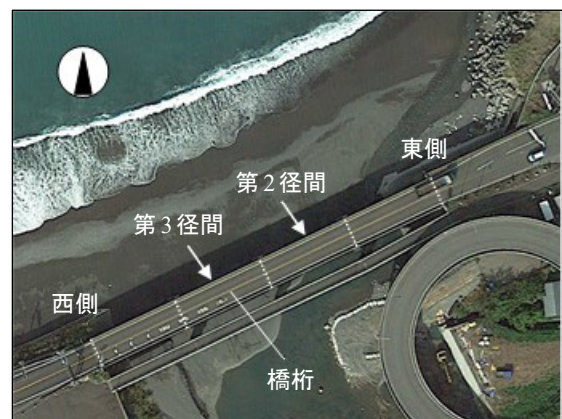
図-1 対象とした橋梁
