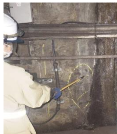
写真-5 打音点検
