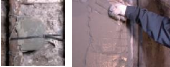
写真-2 犠牲陽極材設置 写真-3 断面修復工
