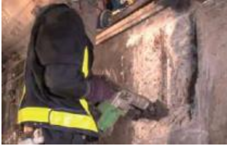
写真-1 劣化部分コンクリートはつり
