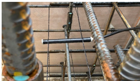
写真-2 計測センサ設置状況
