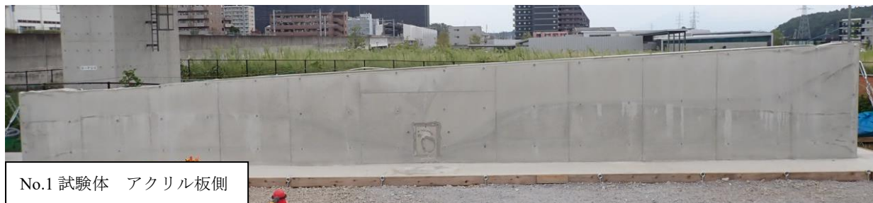
写真-1 脱型後の試験体外観
