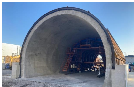
写真-3 脱型後の覆工コンクリート外観
