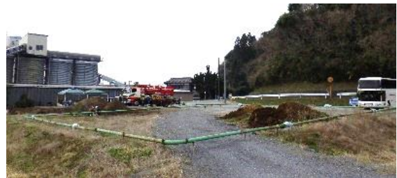
写真-1 試験場の全景
