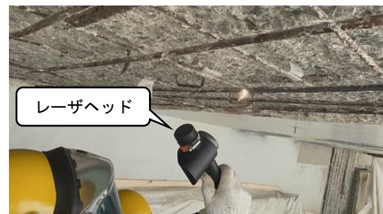
写真-4 レーザ照射状況
