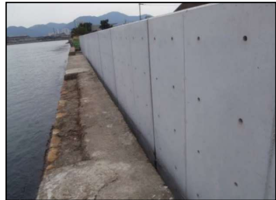
写真-1 構造物の外観
