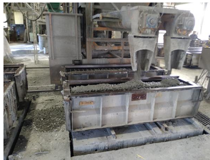
写真-4 PCa製品の作製状況
