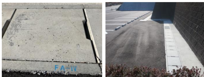
写真-7 PCa製品の設置状況
