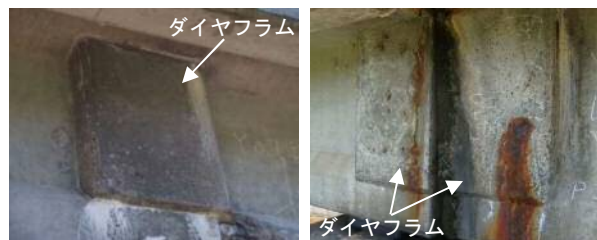
(a) 中間横桁部 (b) 端部横桁部
