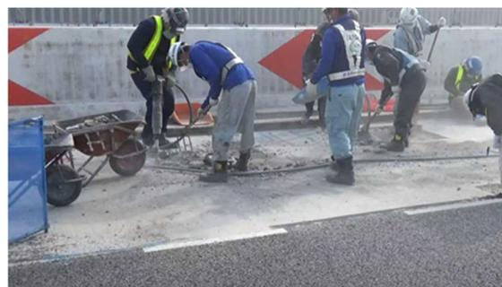
写真-1 従前（ブレーカーによる）の施工状況
