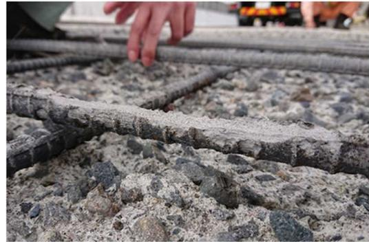
写真-10 鉄筋腐食部分除去状況
