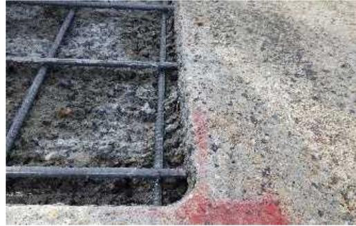
写真-9 端部はつり完了状況
