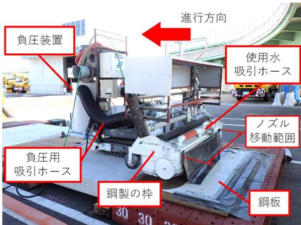
写真-6 使用水処理の工夫
