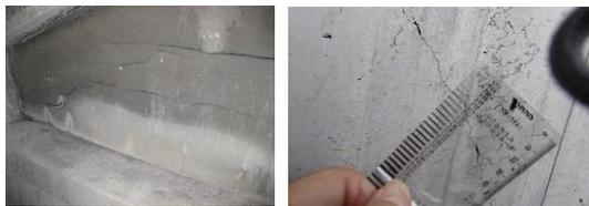
図-1 発生直後のひび割れ画像例（新ひび割れ）
