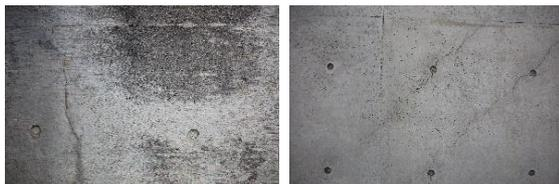
図-2 以前からあるひび割れ画像例（古ひび割れ）
