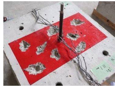
写真-1 試験体接合面の状況
