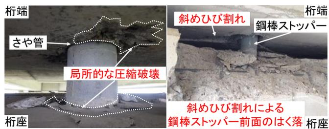
写真-1 実桁に生じた損傷
