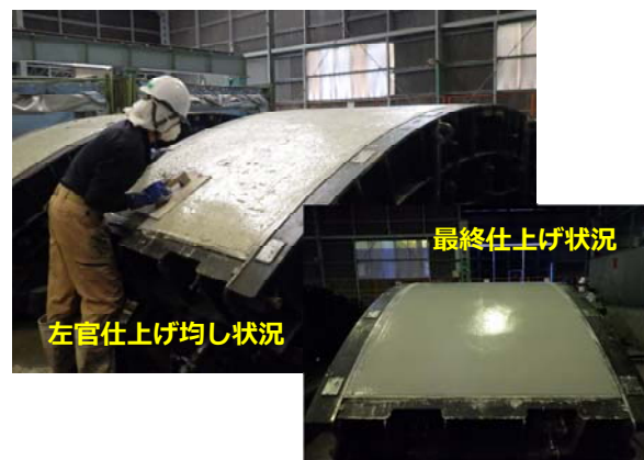
写真-3 セグメント仕上げ状況
