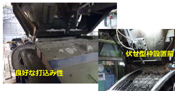
写真-1 セグメント打込み状況
