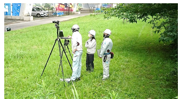
写真-2 ひび割れ画像の撮影状況
