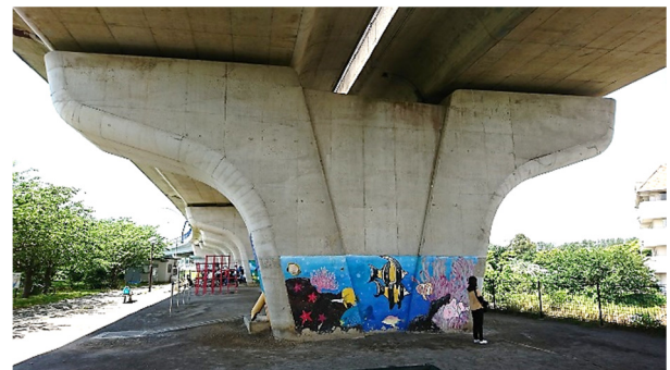
写真-1 高架橋橋脚の外観
