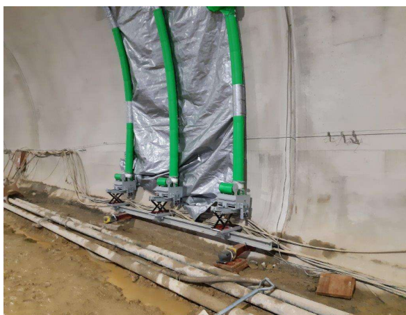
写真-3 養生システムの下端部とジャッキにより高さ調節のできる装置
