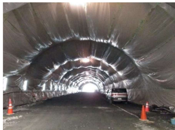
写真-1 参考にした農業用シートによる養生方法
