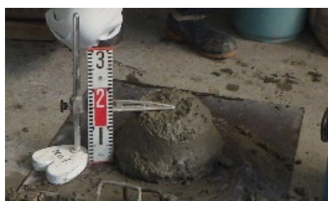
写真-1 スランプ試験
