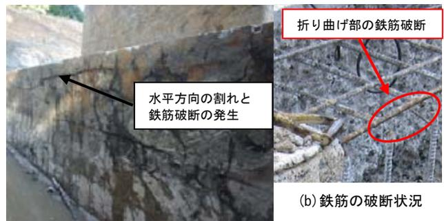
(a) フーチング側面のひび割れ状況
