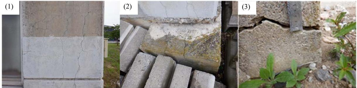
写真-2 建物BのASRによる劣化状況
