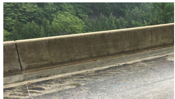
写真-1 コンクリート製壁高欄
