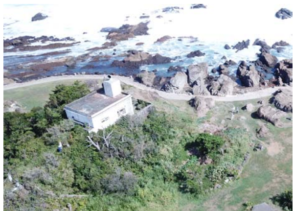
写真-1 対象建物の外観（北西側上空より望む）
