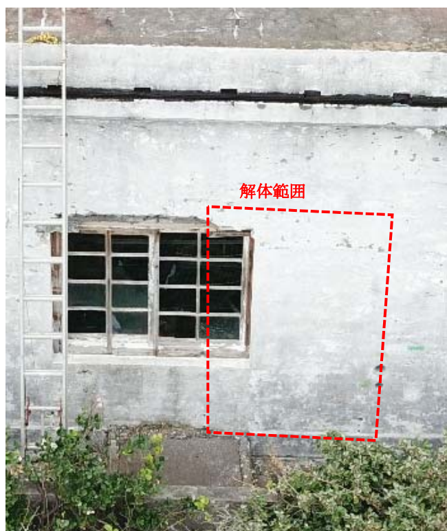
(a) 解体範囲の外観
