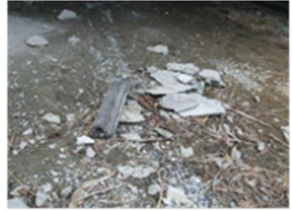
写真-3 落下したコンクリート片
