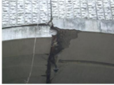
写真-2 ヒンジ部の損傷(その2)
