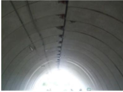
写真-1 ヒンジ部の損傷(その1)
