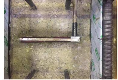
写真-6 打継目の処理状況
