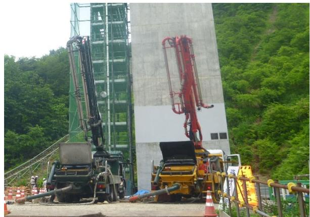
写真-1 コンクリートポンプ車 2 台設置
