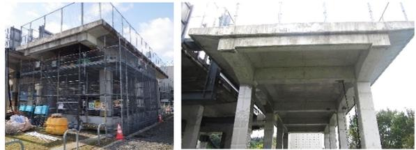
写真-1 実物大模擬高架橋の外観 (試験施工の対象)
