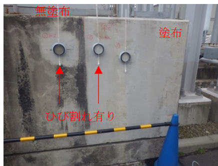
写真-9 透水量試験箇所
