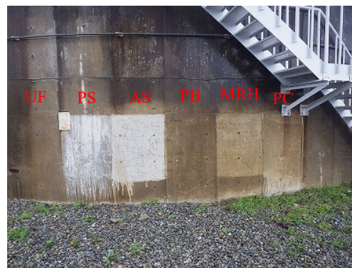
写真－5 雨天時の表面撥水状況（2期塗布）
