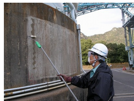
写真-2 塗布状況
