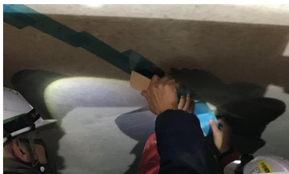
写真-12 硬質ヘラによるシールテープ圧着作業
