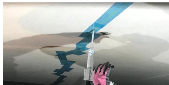
写真-14 注入作業
