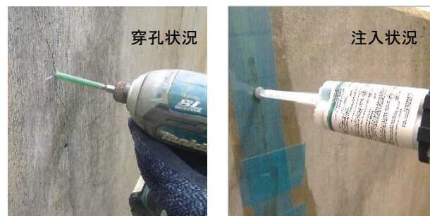
写真-1 シールテープインジェクション工法施工状況
