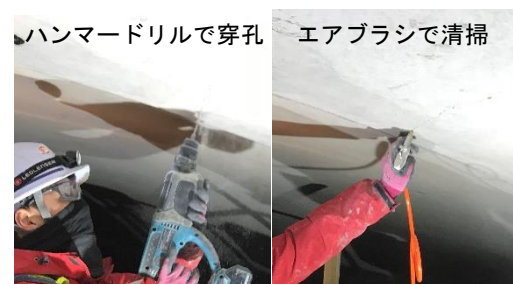
写真-9 穿孔および清掃作業
