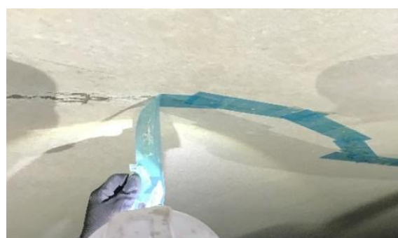
写真-16 撤去作業
