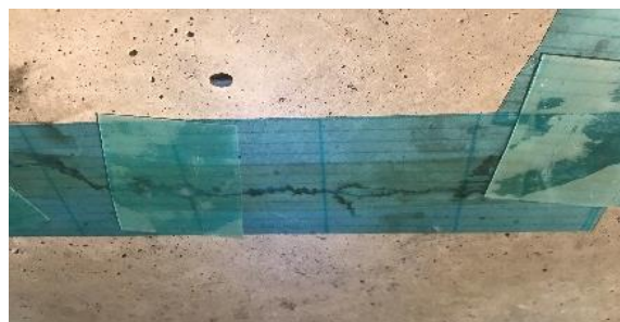
写真-15 充填状況目視確認
