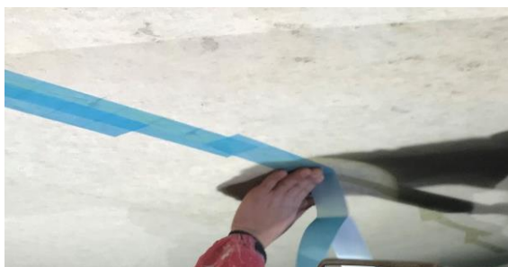
写真-11 シールテープ貼付作業
