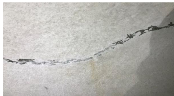
写真-17 仕上がり状況
